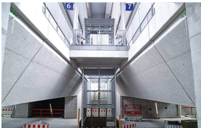
Während an der Oberfläche auf den Gleisen die Züge rollen, wird ein Stockwerk tiefer fleißig gebaut. Hier werden Elemente wie die Rolltreppen und Aufzüge zu den Gleisen installiert.
