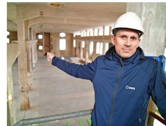
swa KreativWerk-Leiter Stefan Schleifer zeigt das Reinigergebäude. Es wird für 1,8 Millionen Euro saniert.
