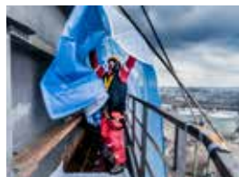
Oberhausen 34 100 Jahre Gaswerk
