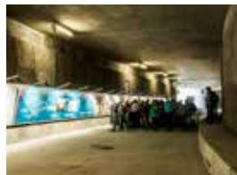
Innenstadt 46 Unter dem Hauptbahnhof entsteht der Tram-Tunnel
